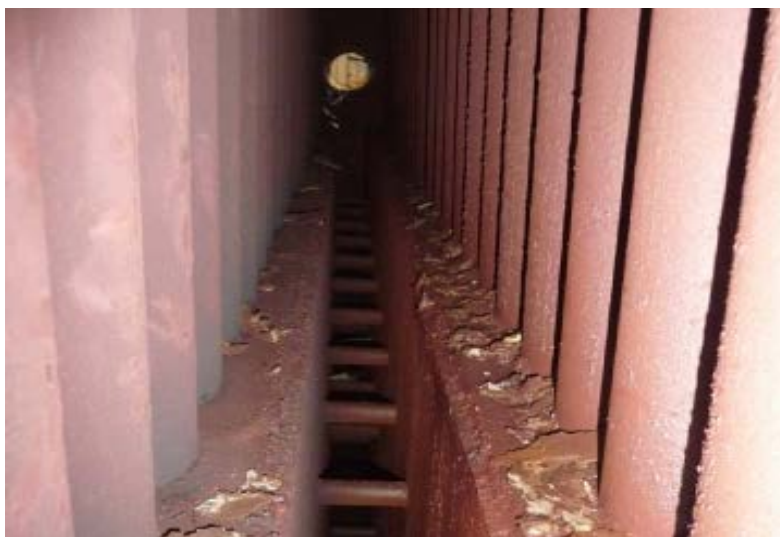
Figur 1: Pannans vattensidan med relativt mycket beläggning ett år innan rekonditionering 6
