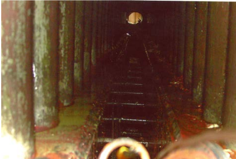
Figur 2: Pannans vattensida efter rekonditionering.
